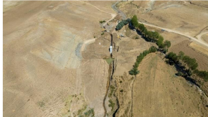
Görsel 3. Baraj İnşaa Alanı
