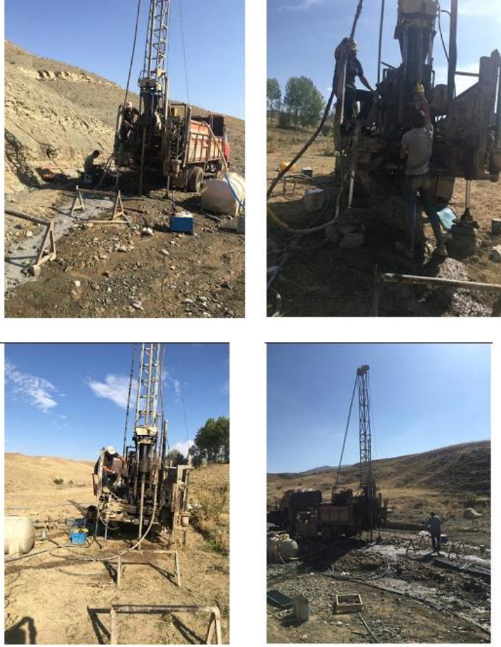
Görsel 4.Sondaj Kuyusu Çalışmaları
