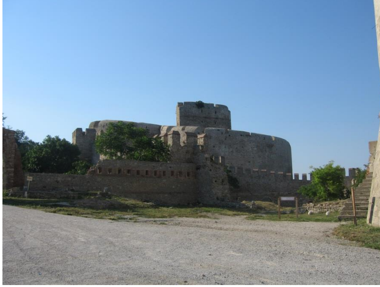
Görsel 3: Kilitbahir Kalesi (karadan görünüş) (Foto: AOÖ)
